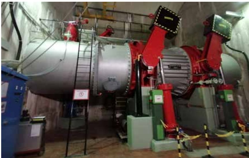
Imposante Technik und Bau im Staudamm Inneren mit 2x 5000kg Gegengewichten (oben). Wem zwickts eis? Selbsteis bei der CKW in Emmen (unten).
